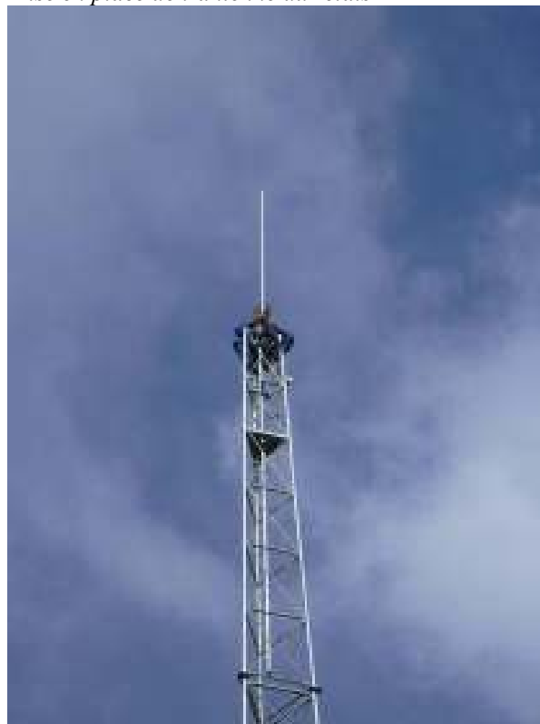
Mise en place de l'antenne du relais
