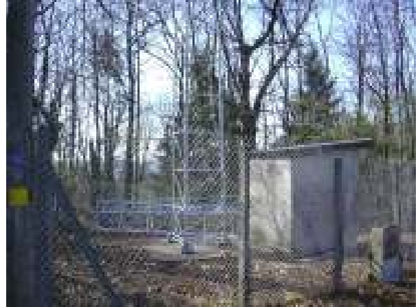
L'élément de base est en place
