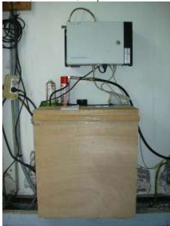
Le relais, et en dessous, le duplexeur
